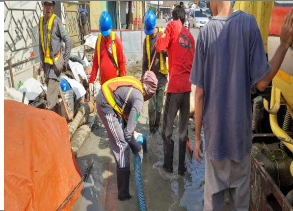
Pekerjaan penyedotan lumpur di pit 0 sta 0+000 Jl. Otto Iskandar Dinata
