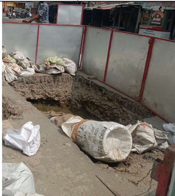
Kondisi setelah penyedotan lumpur di pit 0 dan pembersihan jalan di sta 0+000 Jl. Otto Iskandar Dinata
